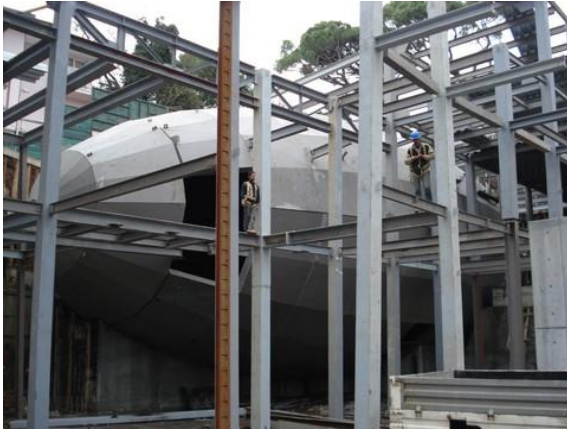
Resim 1. Elipsoit formda ve çelik bir yapıya sahip Çok Amaçlı Salonun dış kabuğu
